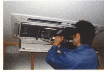
メンテナンス(作業風景)
