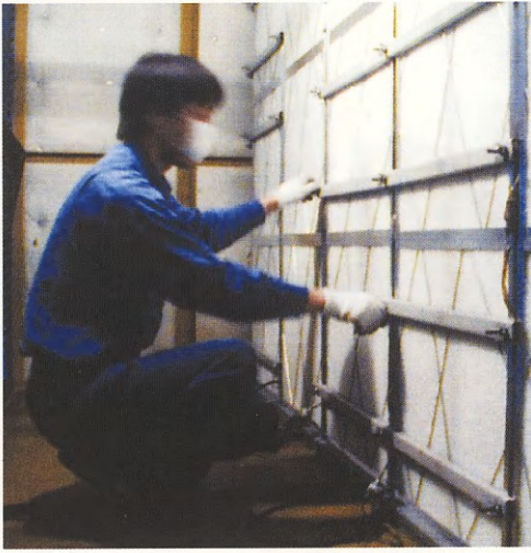
空調機フィルター交換作業中
